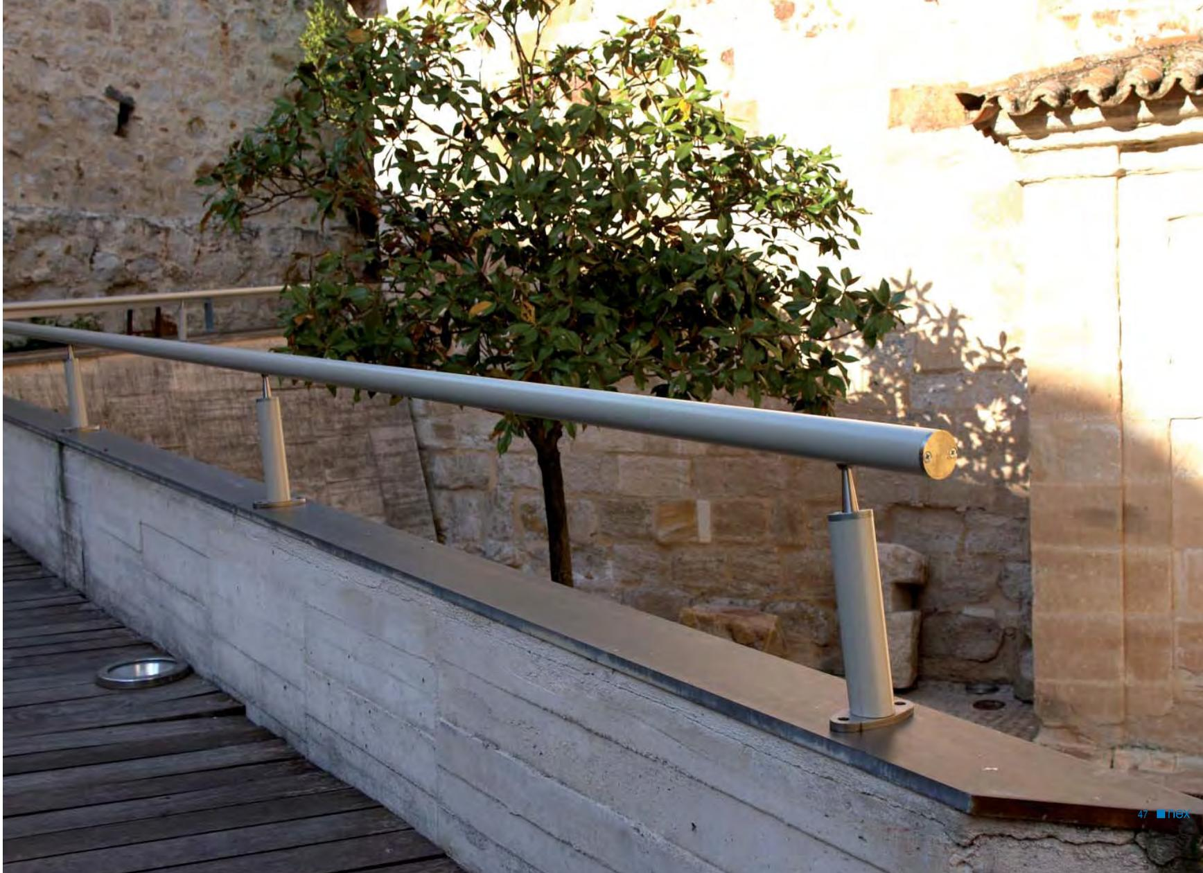
\* Para las fijaciones de los soportes es necesaria una base de hormigón.
